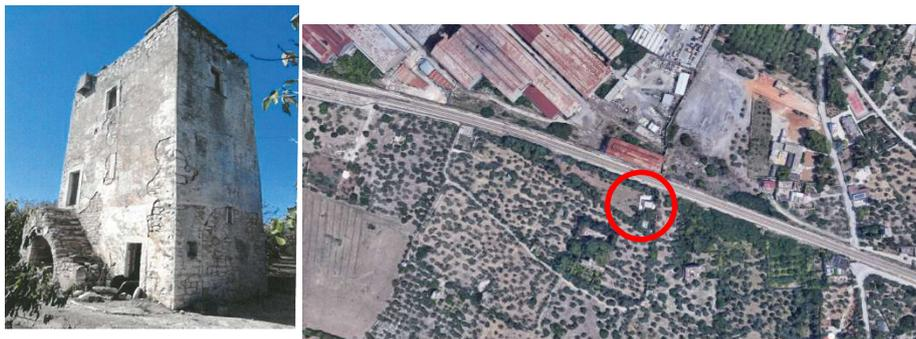
**Torre Recatania (T308)** Torre a pianterreno con annessa costruzione e tipica copertura in chiancarelle; un tempo adibita a frantoio si trova ad oggi in cattivo stato di conservazione.
