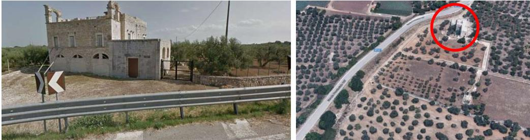
**Torre Modugno (T312)** Torre costruita su due piani con altra piccola costruzione adiacente. E' presente una caditoia in corrispondenza dell'ingresso costituito da un arco policentrico e una nicchia con pozzo; in passato adibita ad abitazione oggi è utilizzata come deposito agricolo. La torre presenta aperture prive di infissi ed uno stato di abbandono in cui si rilevano diversi quadri fessurativi.
